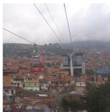
La primera línea de Metrocable construida en 2004, la línea K, tiene una longitud total de 2 km, un total de 4 estaciones, una capacidad instalada de 3000 pasajeros/hora y transporta 35.000 pasajeros/día. Por medio del sistema Metrocable los habitantes de la zona pueden transportarse al metro de la ciudad en menos de 10 minutos y una vez en el metro pueden transportarse al centro de la ciudad en 20 minutos adicionales (J.P. Bocarejo et al, 2012).
